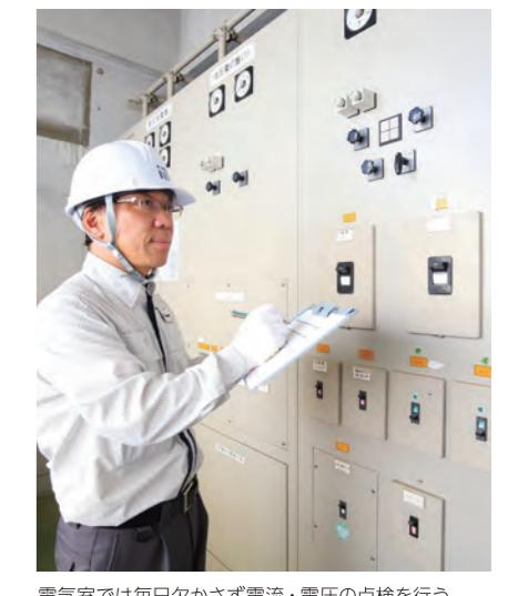
電気室では毎日欠かさず電流・電圧の点検を行う
