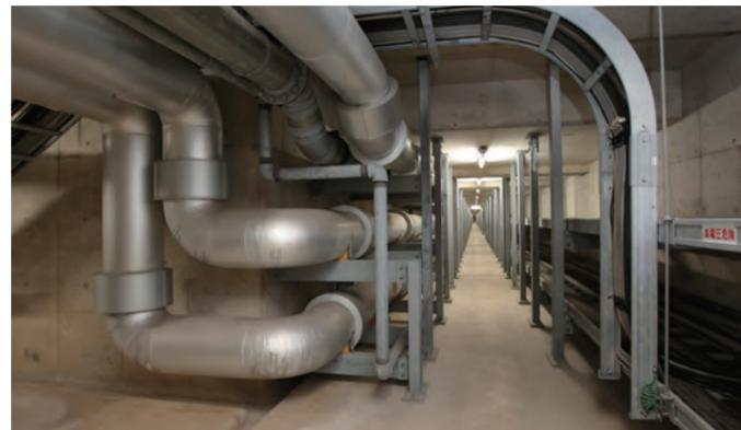
地下共同溝。水道管、冷水管、電気配線等が構築され、エネルギーの搬送、高度情報化、将来の改修のローコスト化に役立つよう計画された
